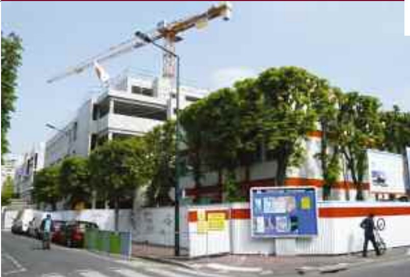
Le chantier du foyer Darty, rue Gambetta, avance à grands pas.
